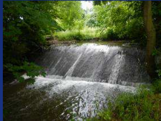
Stat. km 1+030 (Wehr Niedermühle)
