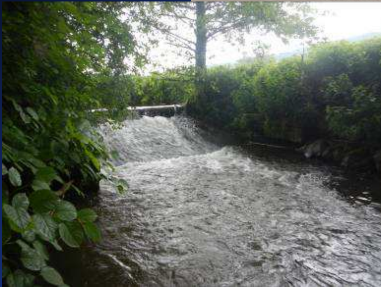
Urff, Station km 0+205 Wehr Absturzhöhe: 1,50 m
